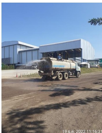
รูปที่ 39 การฉีดพรมน้ำเส้นทางการขนส่งกากตะกอนหม้อกรองและเถ้าภายในโครงการ
