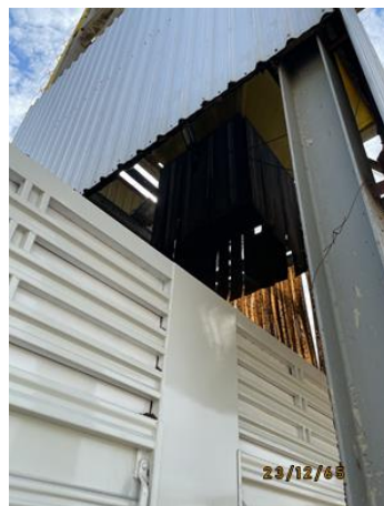
รูปที่ 43 สายพานลำเลียงกากตะกอนหมักทรงแบบปิดครอบ และหัวสเปรย์น้ำ บริเวณพื้นที่การขนถ่ายลงรถบรรทุก
