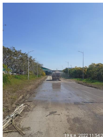
รูปที่ 39 การฉีดพรมน้ำเส้นทางการขนส่งกากตะกอนหม้อกรองและเถ้าภายในโครงการ
